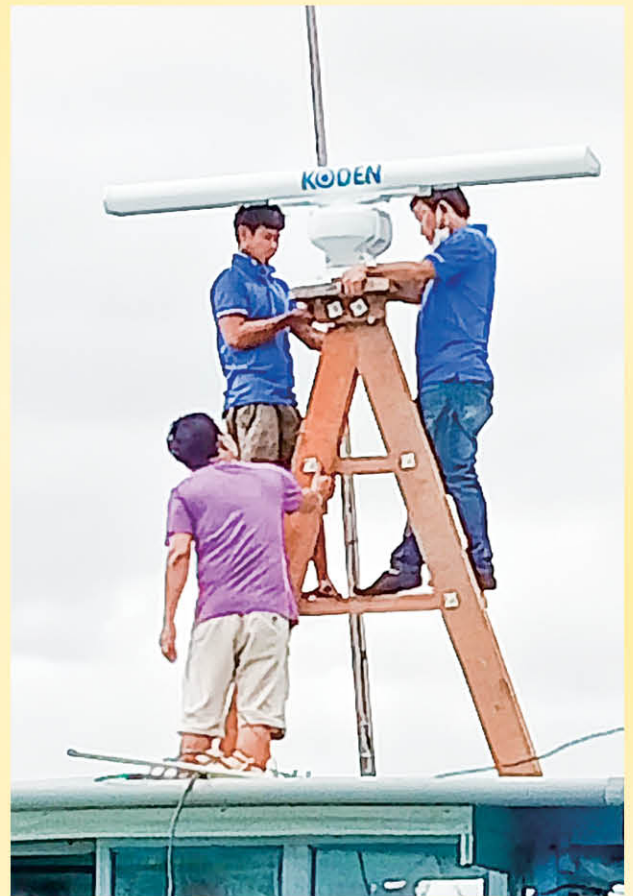
Thi công lắp đặt Radar
